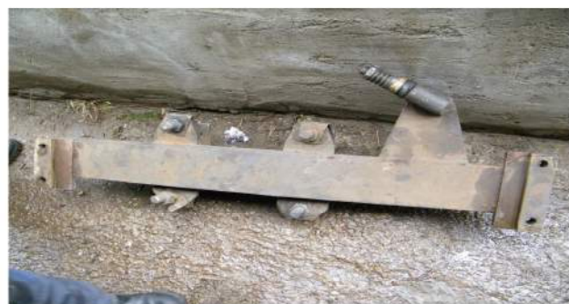
Legătura de gardă osia 6 desfăcută din cele 4 șuruburi de fixare
