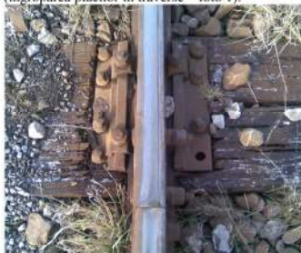
Foto1 : Placă metalică îngropată în traverse pe firul interior al curbei
