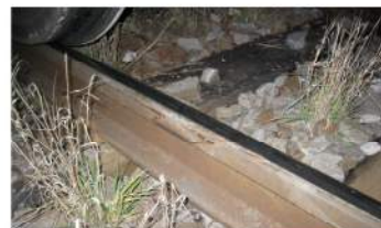
Foto 5 : Amprenta roţii din stânga la căderea în exteriorul căii
