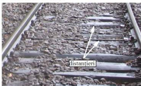
foto nr.5 - prindere consolidată cu distanțieri la km 21+900
